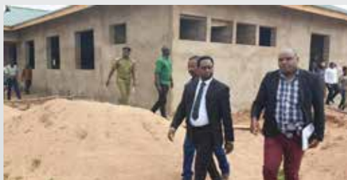
Naibu Waziri, Dkt. Festo Dugange akikagua maendeleo ya ujenzi wa Hospitali ya Wilaya ya Gairo
